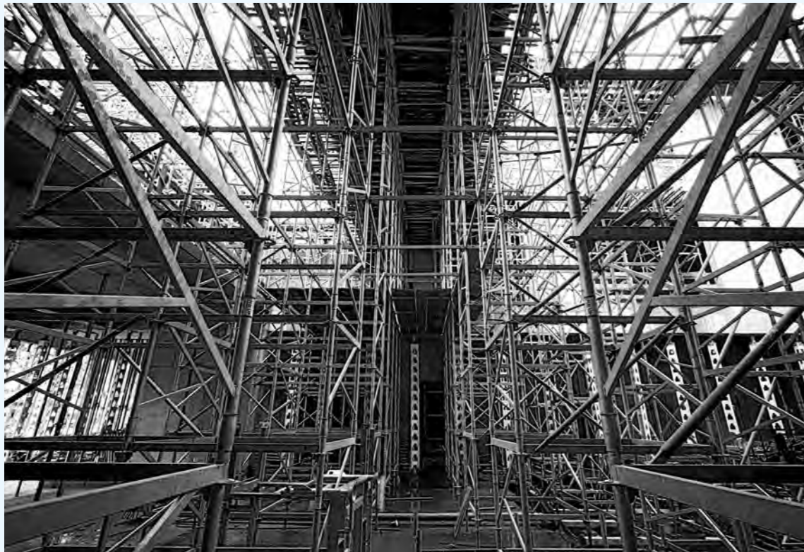
Baustellenansicht Museum Reinhard Ernst, © Karl-Martin Hartmann und Museum Reinhard Ernst
