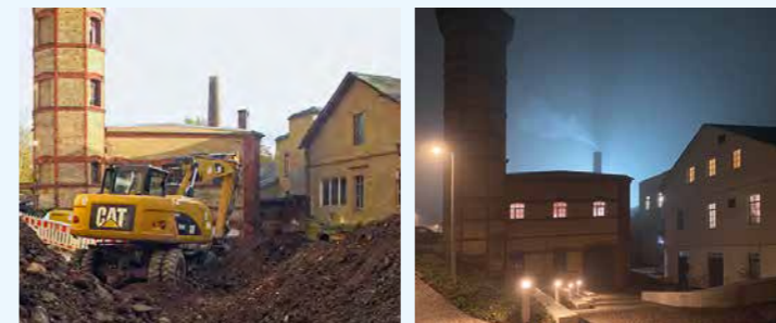
Ein Blickwinkel – zwei Welten: Der obere Zugang zur Walkmühle während und nach der Sanierung. Foto: ©Christiane Erdmann/Künstlerverein Walkmühle.
