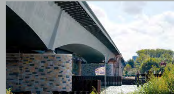
Ersatzneubau Rheinbrücke Schierstein Unsere Leistungen: Statisch-konstruktive Prüfung der Überbauten, Prüfung der Ausführungsplanung der Überbauten und des Abbruchs
