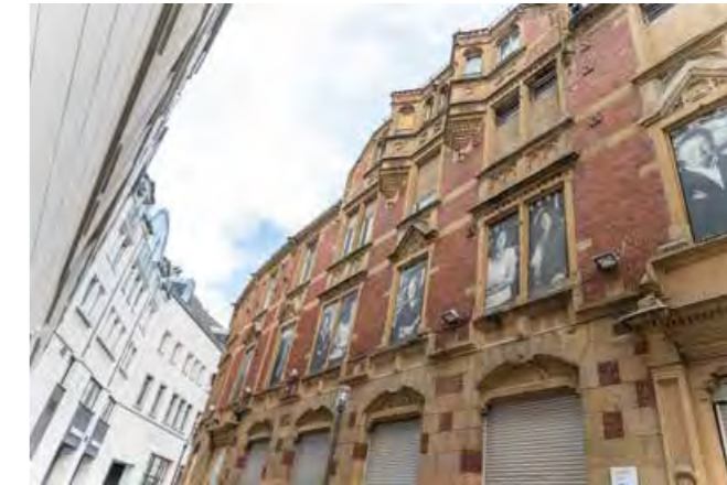
Wird der Klinkerbau von 1910 abgerissen?
