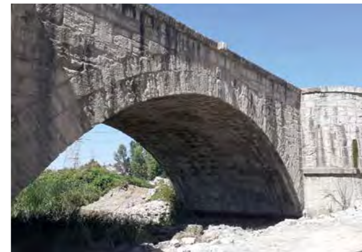
Kaiser Justinians Brücke in Sakarya wird saniert und soll Besuchermagnet werden
